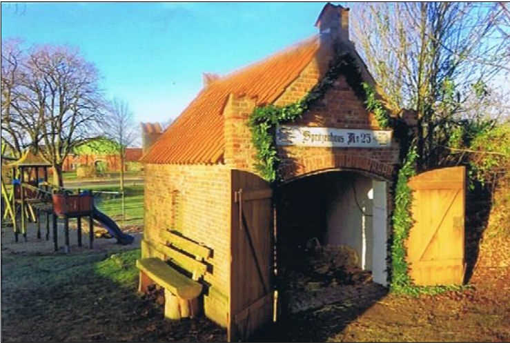
Weißes Schriftfeld: „Spritzenhaus No. 25“ über dem Einfahrtstor des Schönbeker Spritzenhauses
