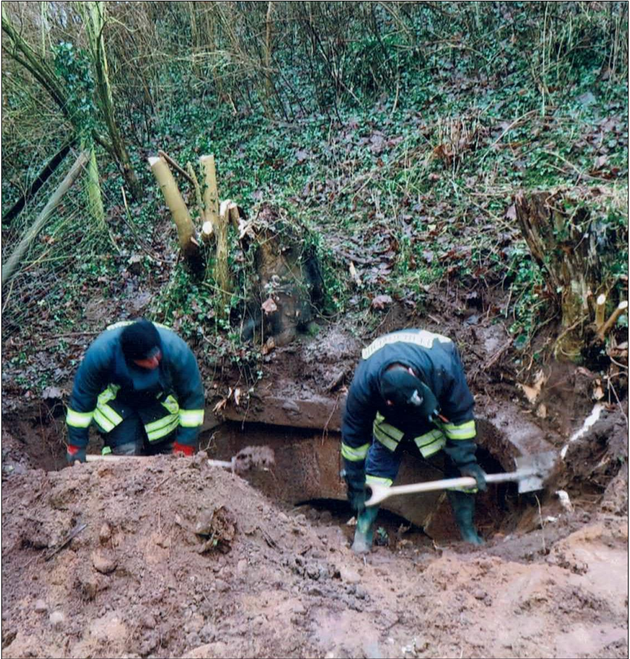
Der Eingang der Rothenhahner Brücke ist freigelegt. Das Mauerwerk ist erkennbar. (Foto: Rolf Pohlmeier)
