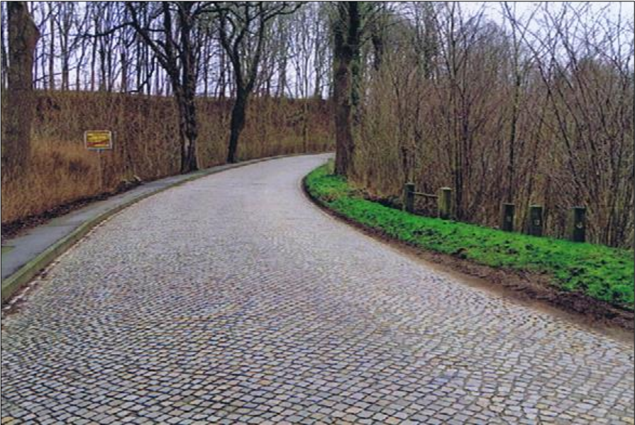
Der Straßendamm der alten Chaussee-Trasse in Rotenhahn oberhalb der Brücke. Rechts im Bild die vorhandenen Geländefeiler. Das Kopfsteinpflaster wurde 1924 gesetzt und besteht aus Granit-Lesesteinen. (Foto: Rolf Pohlmeier)
