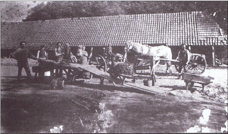
Die Brockstedtsche Ziegelei in Negenharrie; Arbeit am Streichtisch, im Hintergrund die große Trockenscheune mit Ziegeldach (Foto: Gemeinde Negenharrie: Negenharrie 1988, Ludestesharegen - Negenharrie 1238; Wulverdesharegen - Fiefharrie 1238)
