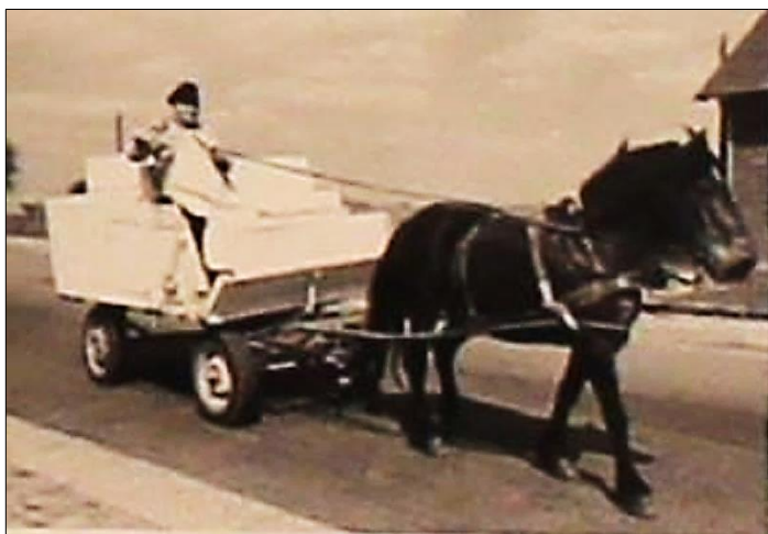
Abb. 19: Hans Hamann, genannt Hein Bottermelk, versorgte die Siedlung in den ersten Jahren per Pferd und Wagen mit Milchprodukten. Quelle: AG Heimatsammlung: Bordsesholm vor fünf Jahrzehnten. Bordsesholm 2005, S. 111.
