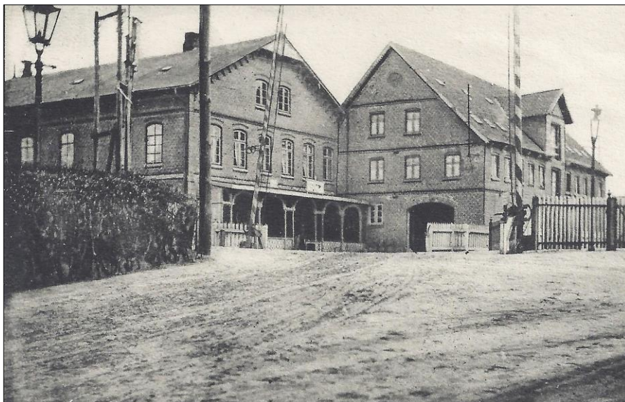
Kornhändler Heitmann an der Bahnstation (Foto: Archiv Wiebke Stöllger)
