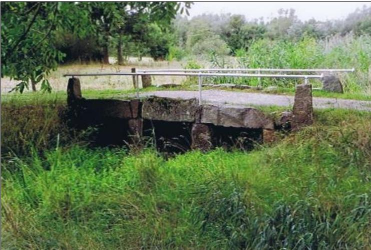
Die Brücke aus Rimmels ist aus großen, behauenen Granitsteinen errichtet. Sie hat drei Durchlässe mit Stromabweiser. Ursprünglich führte sie über die Papenau nördlich von Hohenwestedt. Die Steinbrücke ist um 1800 gebaut worden.
