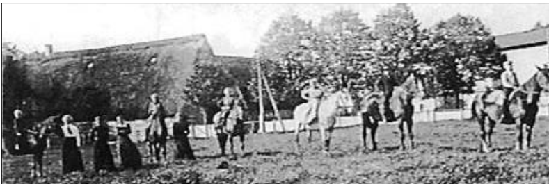
Im Hintergrund die reetgedeckten Gebäude der Hufe 2 von der Hauskoppel aus gesehen. (Foto: Müller/Heeschen, S. 137)
