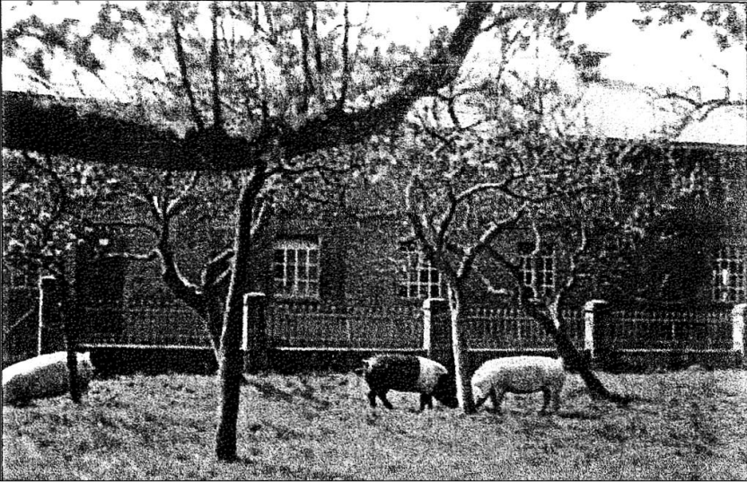
Altenteil und Zugang zum Hofgelände lagen an der Twiete, einem privaten Verbindungsweg von der Dorfstraße zum See
