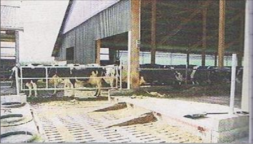
Futtertisch mit hydraulisch klappbarer Futtertischbrücke erleichtert den Seitenwechsel und die Trennung von Futter und Ausscheidungen der Tiere (Fotos: Archiv Claus Reese)
