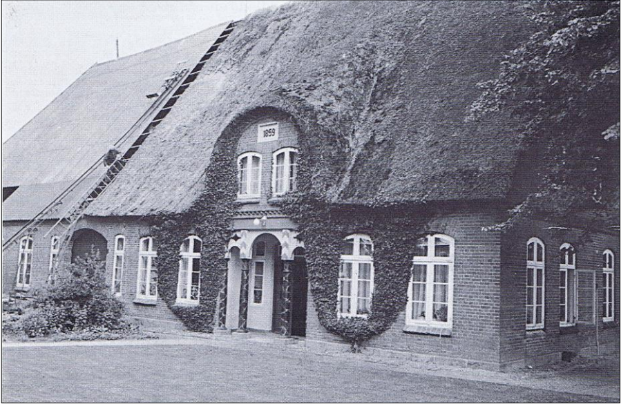
Das Haus 1966, links das neue Eternitdach (Foto: Sarnow, S. 98)
