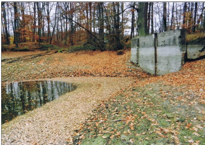
Der Heickenteich wurde gerade abgelassen
