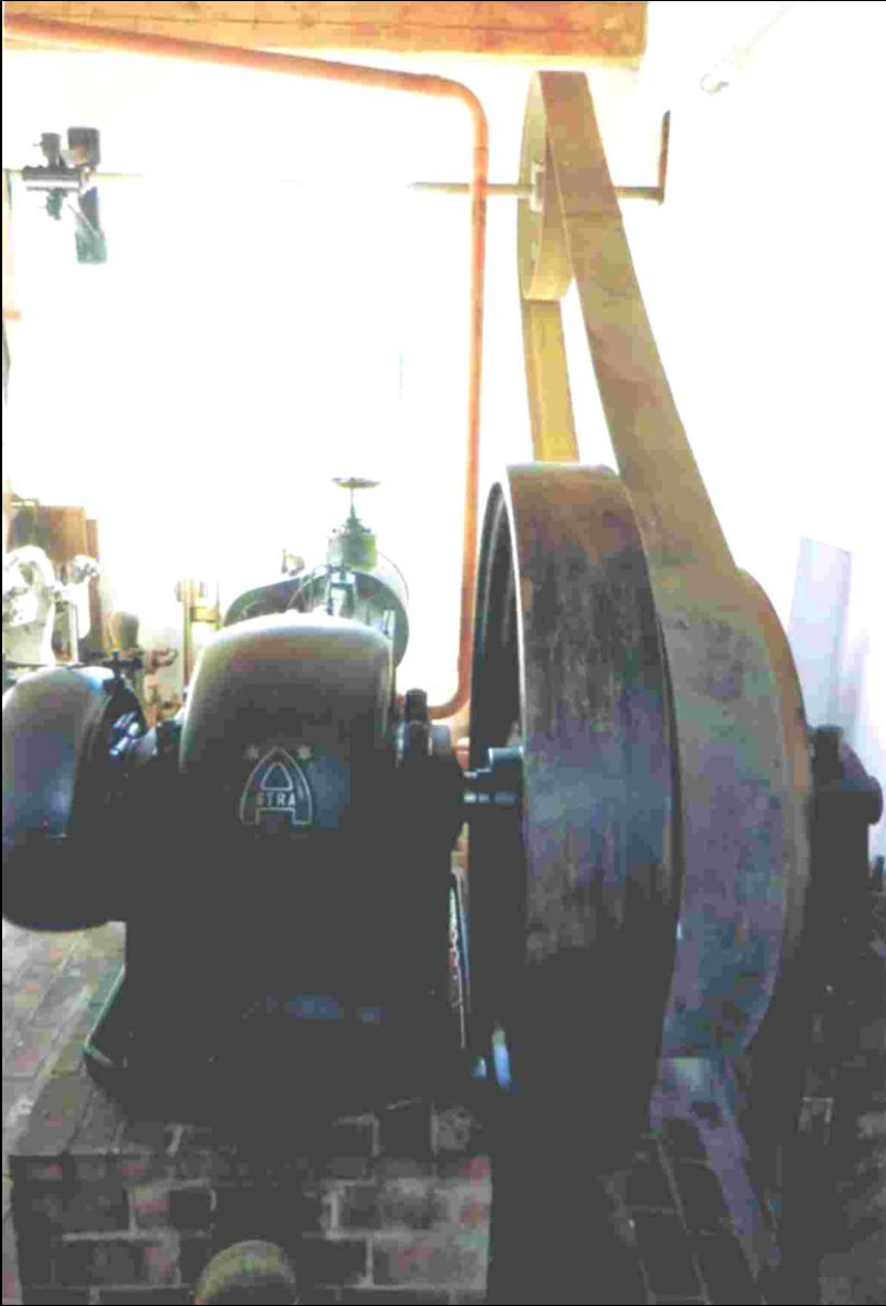
Die Dampfmaschine besteht aus dem Dampfzylinder, der Kurbelstange und dem Schwungrad, der die Kraft gleichmäßig auf die Transmission überträgt und die Apparate antreibt.
