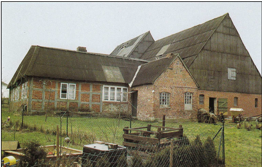
Wohn- und Wirtschaftsgebäude der 1995 abgerissenen Halbhufe Steffens/Horn/Voß (Foto: M. Kopischke - Quelle: Hildebrandt, H.: Mielkendorf, Kiel, 1995)
