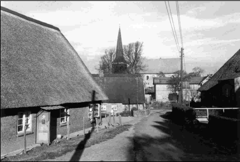
Sandberg 2 mit Transformatorenhaus
